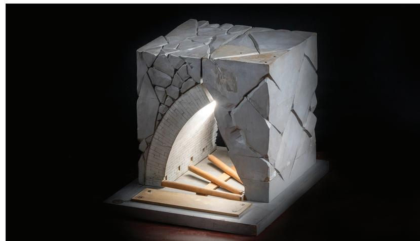
Рис. 3. Подпорный свод. Каменное крепление при выходе в боку выработки слабых пород. Фрейберг, Германия. 1820-е гг. Макет. Из коллекции Горного музея.
