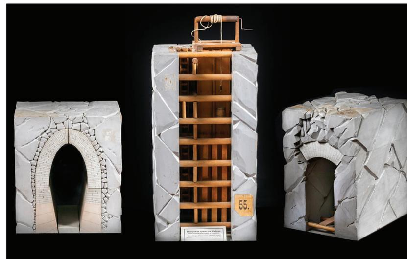
*Рис. 4. Венцовая крепь на бабках для неглубоких шахт и шурфов. Фрейберг, Германия. 1830-е гг. Макет. Масштаб 1:16. Из коллекции Горного музея.*
