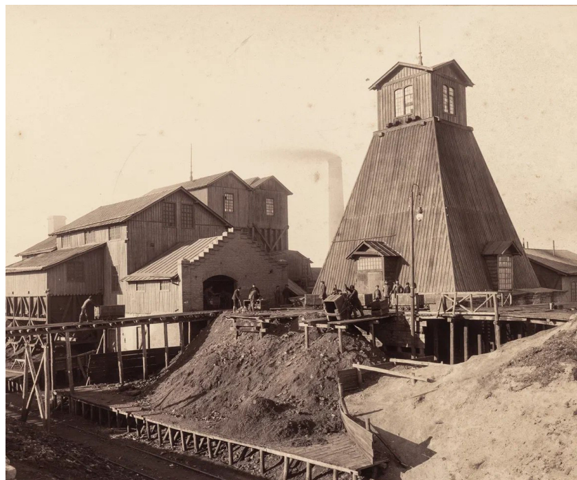
Надшахтное здание Берестовской копи со стороны подъездных путей. Донбасс. Конец 19 века. Из коллекции Горного музея
