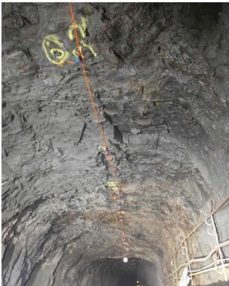
Рис. 3. Пример расположения геофона в кровле горной выработки (Норильский подземный рудник – профиль 2 в таблице 1)
