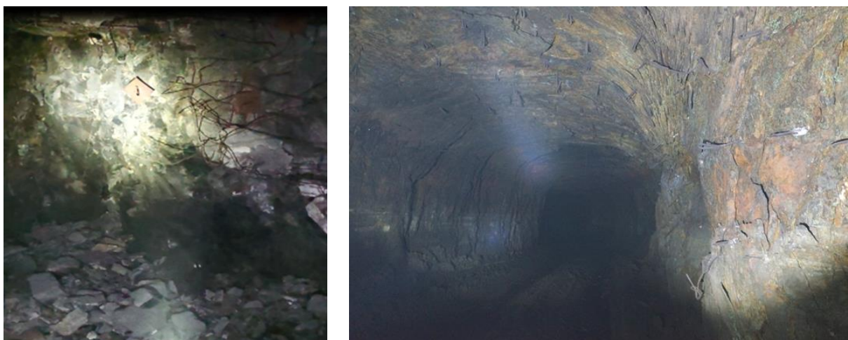
Рис.2. Примеры отслоения руды в приконтурном массиве под действием высокого уровня напряжений
