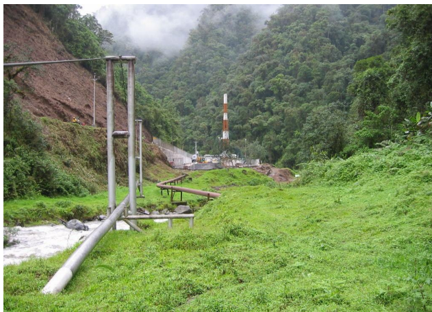
Прокладка нефтепровода над водной преградой в районе Куэнка
