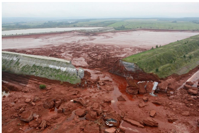
Рис.1. Экологическая катастрофа: прорыв ограждающей дамбы хранилища красного шлама в Венгрии (2010 г.)
