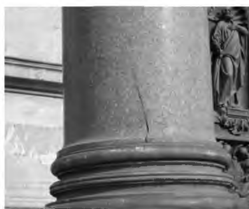
Трещины скола в нижней части колонн западного портика Исаакиевского собора
