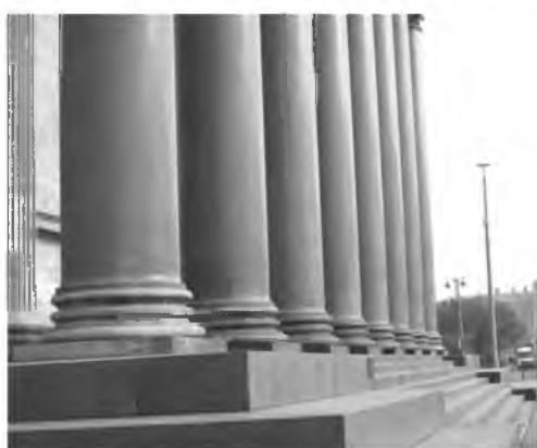
Трещины скола в нижней части колонн западного портика Исаакиевского собора
